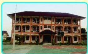
GEDUNG ASRAMA PUTRA
